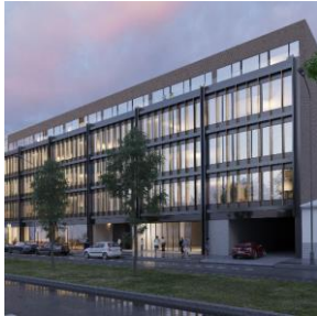
Astrid Office, Prag VF: 4.000 m 2 Fertigstellung: Q2/21
