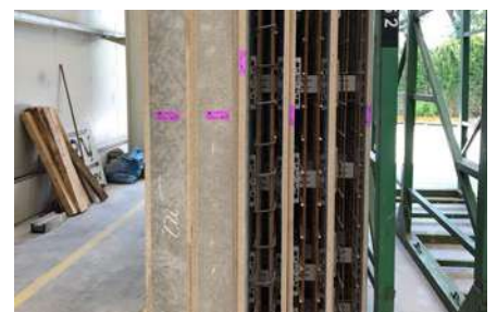
Vorgefertigte Elemente werden per Spedition zur Baustelle transportiert
