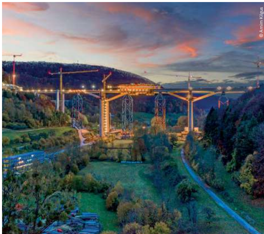
Die Filstalbrücke zählt mit einer Höhe von ca. 85 m zu den höchsten Eisenbahnbrücken Deutschlands.
