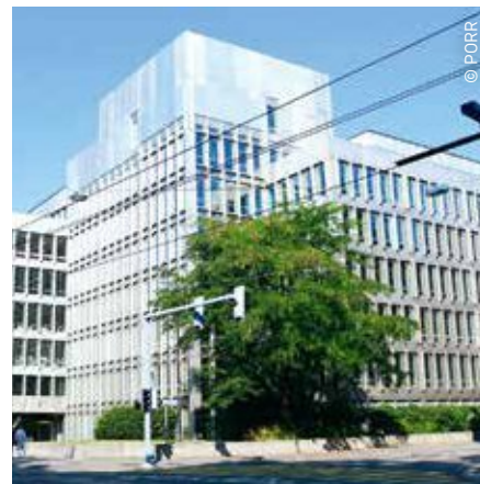
Ressourcenschonende Sanierung des Geschäftshaus Schader am Ufer des Zürichsee.
